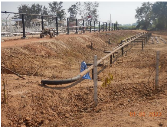
การติดตั้งฐานวางท่อและการจัดเรียงท่อ บนฐานวางท่อเพื่อรอการเชื่อมประกอบ
